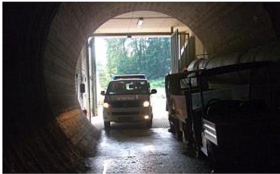
Zeitgleich werden zwei solcher Beileitungstollen von den Ablagerungen gereinigt. Die Länge eines jeden Stollen beträgt hier mehr als 6.000 m. In der Mitte kommen die beiden Beileitungstollen zusammen. Dort ist die Notrufzentrale für 24/7 Stunden/Tage eingerichtet. In diesem Einsatzbereich konnte bisher kein
