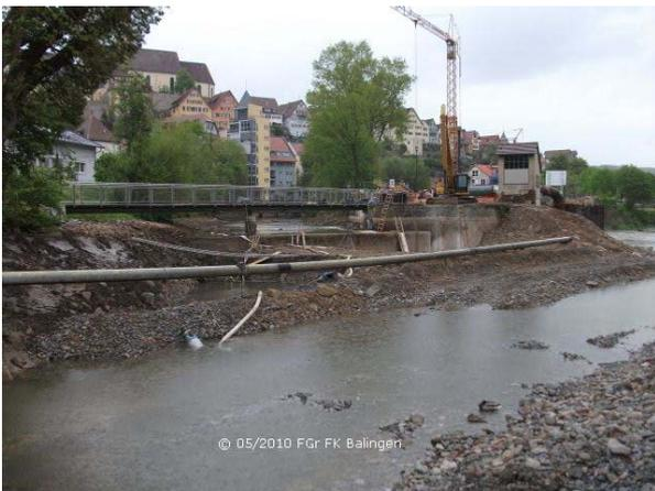
Im Neckar wurde ein Hilfsdamm errichtet, welcher die Wassermassen des Neckars umleiten sollte. Die Baulücke füllte sich jedoch immer wieder, so dass von Seiten des Auftraggebers die Erstmaßnahmen verlängert worden sind.
